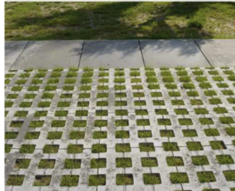
Zona de aparcamientos
